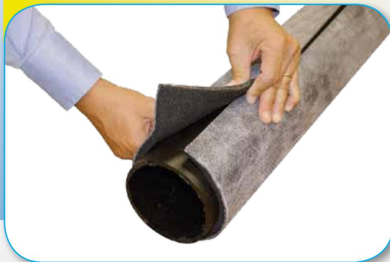
Обмотайте трубу с наложением 10 ÷ 20 мм
