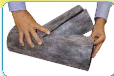
Установка на участках специализированных отводов с наложением 10 ÷ 20 мм
